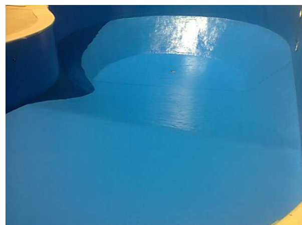
6. Schritt: Das Endergebnis nach Auftragen von Paintchlore, transparent
