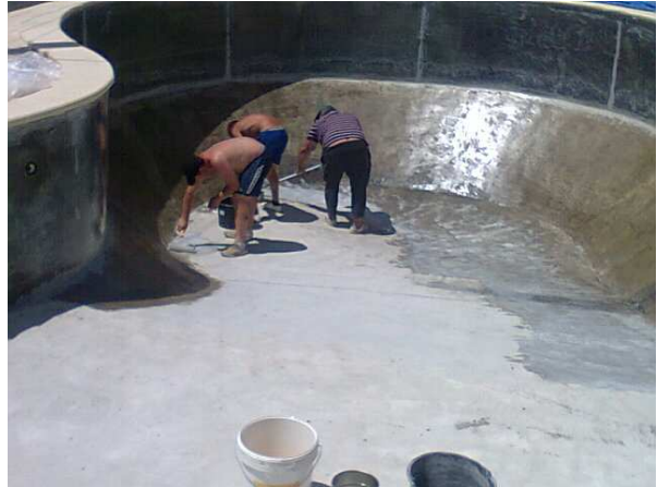
4. Schritt: Auftragen von Impermax, blau
