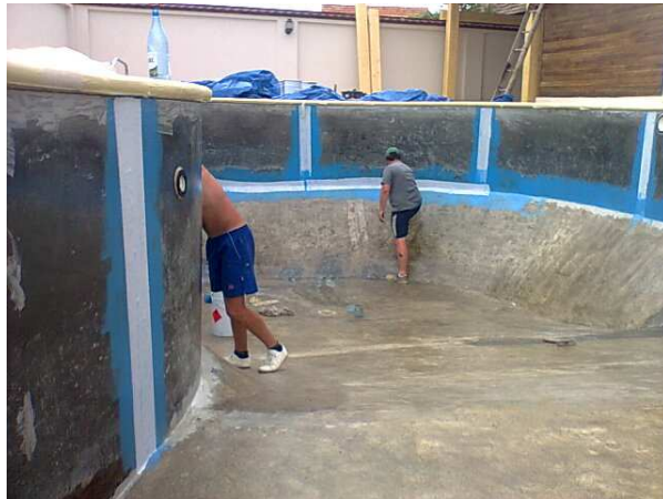
5. Schritt: Anbringen einer weiteren Impermax-Flüssigfolienschiicht
