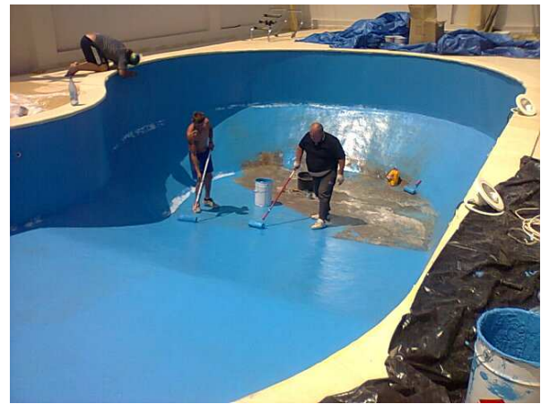
6. Schritt: Das Endergebnis nach Auftragen von Paintchlore, transparent
