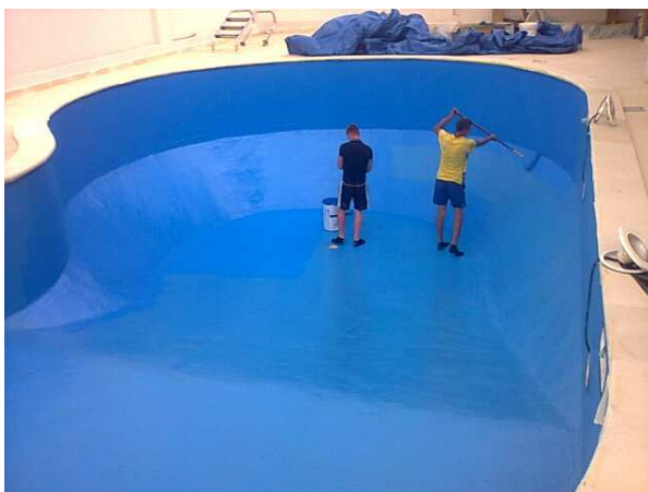
5. Schritt: Anbringen einer weiteren Impermax-Flüssigfolienschiicht
